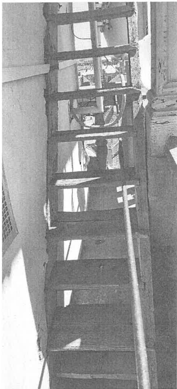
5. Zadní JZ ochoz, fošnové schody vedoucí do krovu věže, u balustrády prochází ocelové táhlo spojující levá a pravá madla balustrády na zadní straně věže
