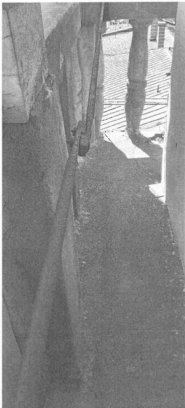
3. Levý JV ohoz, nefunkční (prověšené) táhlo spojující přední a zadní madla balustrády na levé straně věže
